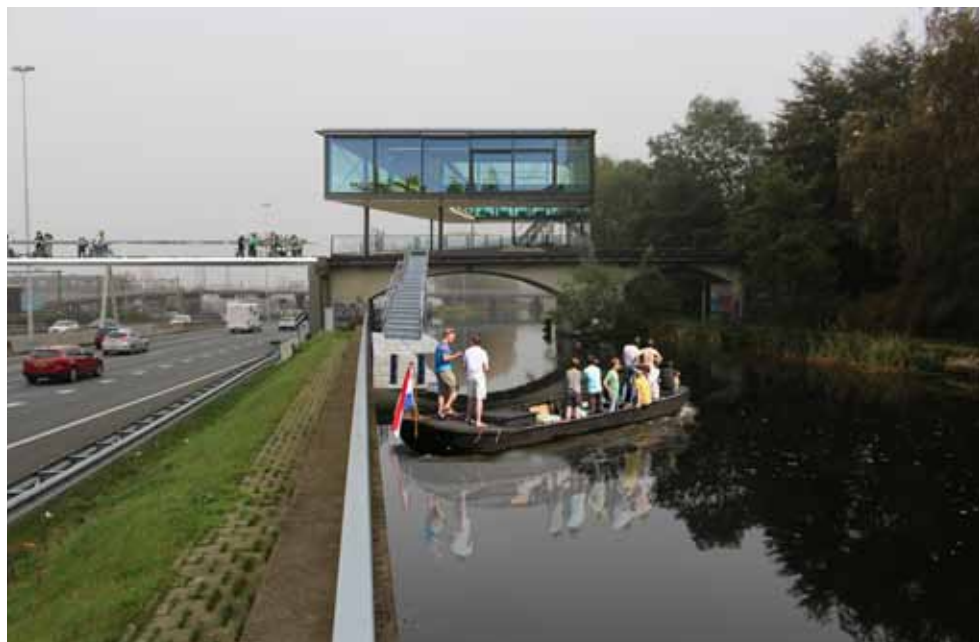
De nieuwe uitzichttoren boven het kanaal
